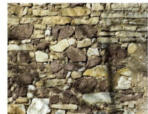
Appareillage de gros et petits moellons non assisés, non équarris et montés au mortier de chaux et sable.
