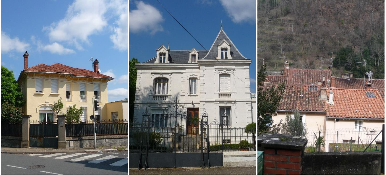
Les principaux matériaux de couverture des toitures des édifices Mazamétains : tuiles mécaniques, ardoises et tuiles canal
